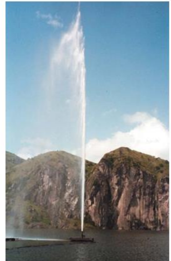
Perairan dalam di Danau Nyos dipompa ke permukaan untuk menghilangkan gas CO 2 yang terlarut.
